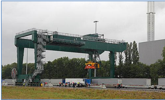
Bild 3 : Der neue Portalkran der HGK (Foto: HGK)
