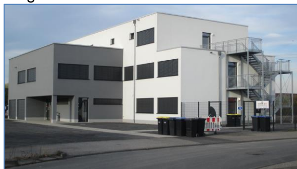
Bild 7 : Das neue Infozentrum – etwas unscheinbar und leider ohne Beschilderung (Foto: B. Klais)
