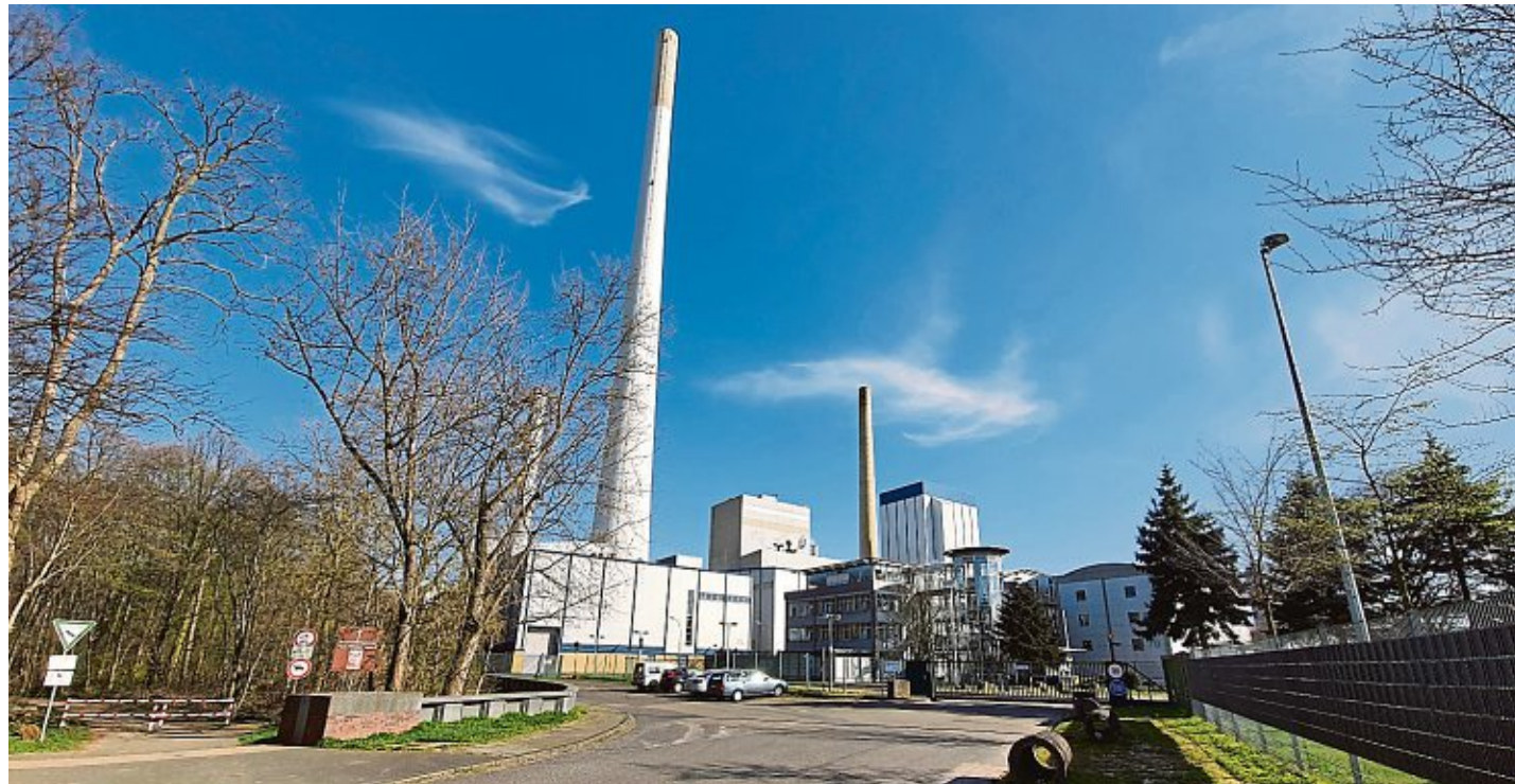
Das Heizkraftwerk in der Merkenicher Hauptstraße soll statt Braunkohle demnächst Klärschlamm verbrennen.
